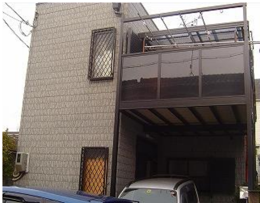
(グループホーム藍・外観)
